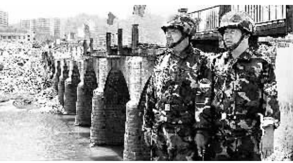
图为爆破现场已经封闭
